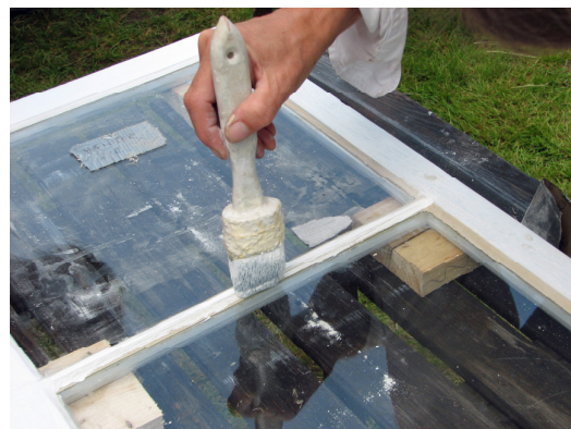
Slutstrykning av bågen med linoljefärg.
