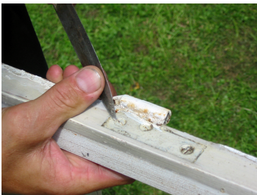
Avlägsnande av gångjärn och beslag.
