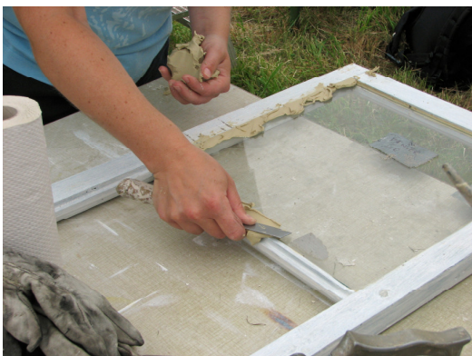
Kittning av fönsterglasen.
