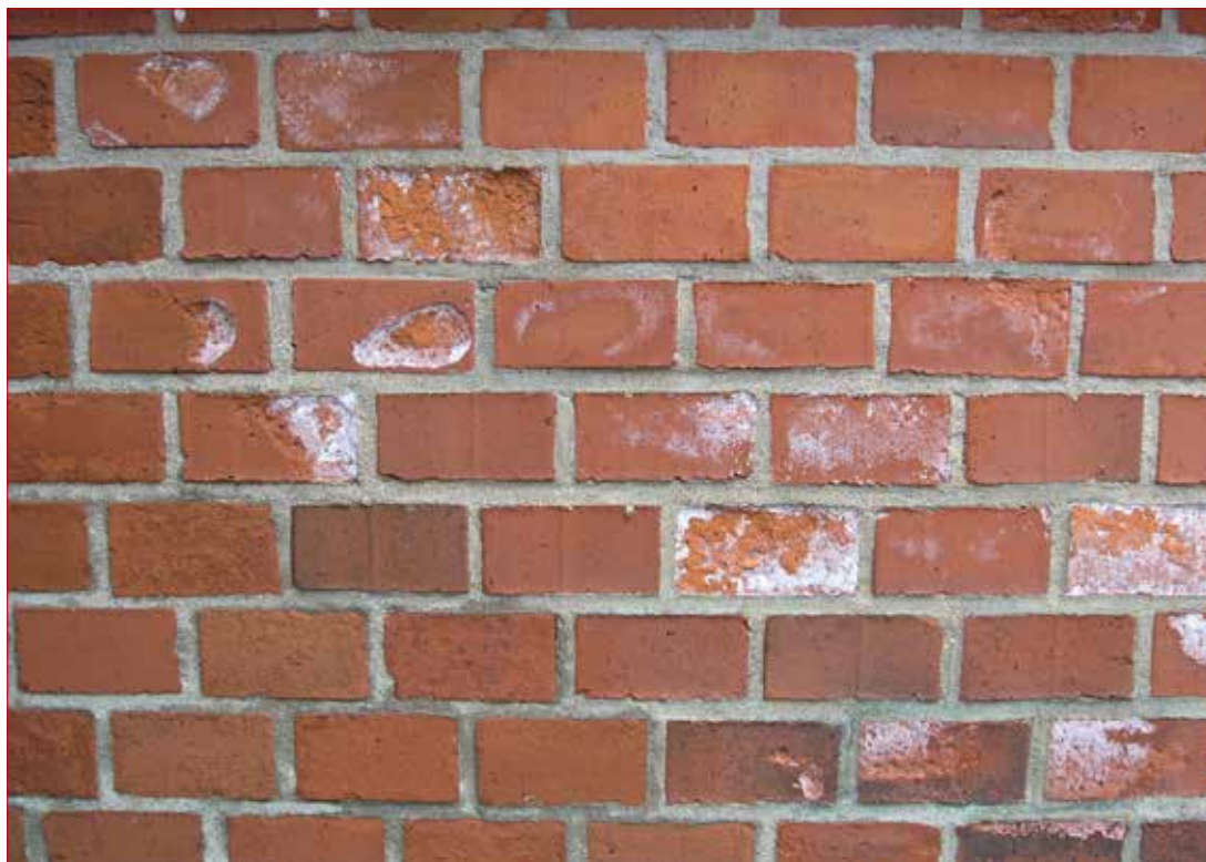
Figur 6.8. Problematiskt sekelskiftesmurverk, Fässbergs kyrka 2007. Saltsprängning på grund av att murverket inte kan hantera fukt. Foto: Tomas Brandt, Bohusläns museum.
