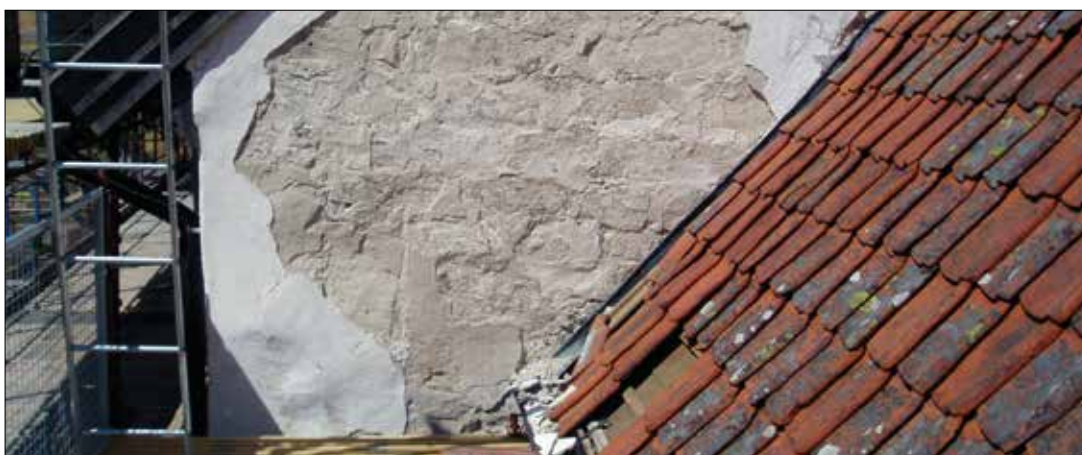
Figur 6.2 Bristande avvattning leder till fukt i intilliggande byggnadsdelar. Bokenäs kyrka 2008, nedfrusen puts på grund av otillräcklig avvattning. Foto: Tomas Brandt, Bohusläns museum.
