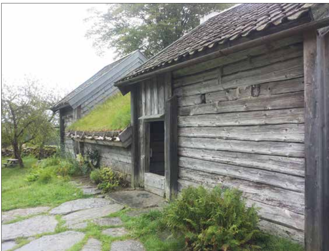
Figur 6.10. En av byggnaderna i Äskhults by. Timmerstommarna är en omistlig del av byggnadskonstruktionen, men är samtidigt del av fasaden. Ett fungerande skalskydd i form av tätt tak, avvattning och tillräckligt dränerande mark är nödvändigt. Foto: Tomas Brandt, Bohusläns museum.
